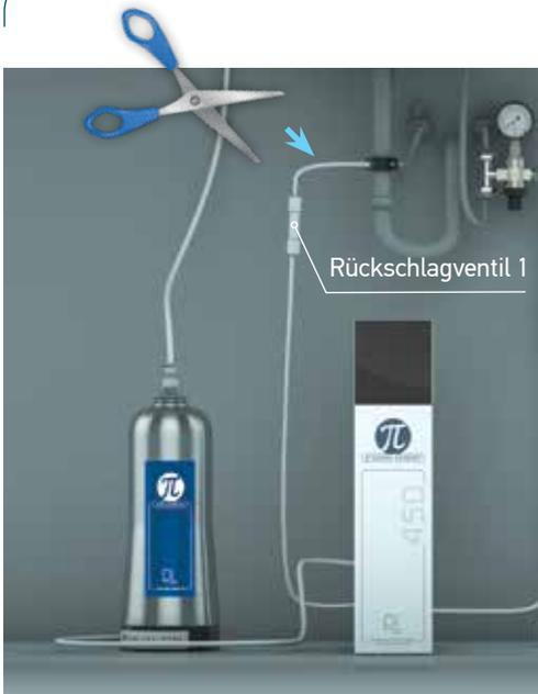
Bitte durchtrennen Sie die Abwasserleitung (DRAIN) nach dem bereits eingebauten Rückschlagventil 1 (RV1).
