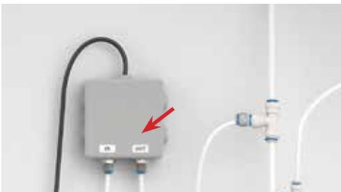
Verbinden Sie das Rückschlagventil mit dem Magnetschalterventil OUT.
