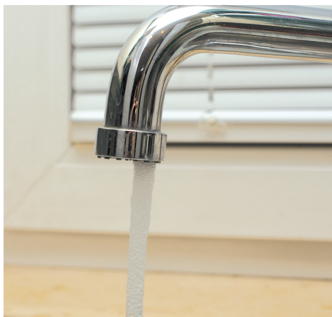
Acqua di condotta (calda/fredda)
